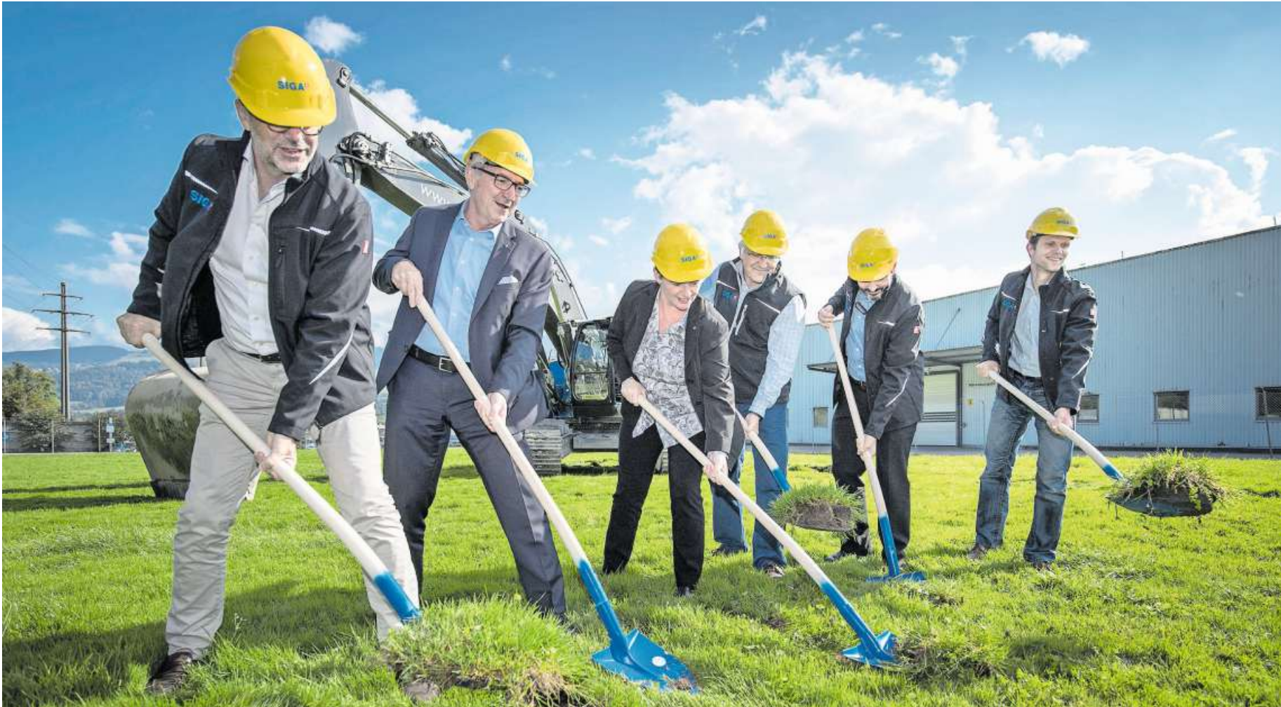
Spatenstich der Firma Siga am Standort Schachen: Zur Schaufel griffen (von links nach rechts) Firmeninhaber Marco Sieber, Regierungsrat Robert Küng (FDP), Kantonsratspräsidentin Vroni Thalmann (SVP), Firmeninhaber Reto Sieber, Firmen-CEO Patrick Stalder und Projektleiter Rafael Hunziker. Bild: Plus Amrein (27. September 2017)
